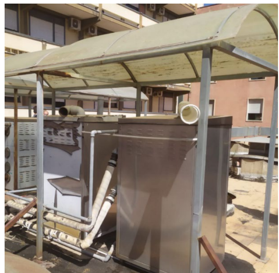
Generatore termico ACS esistente
